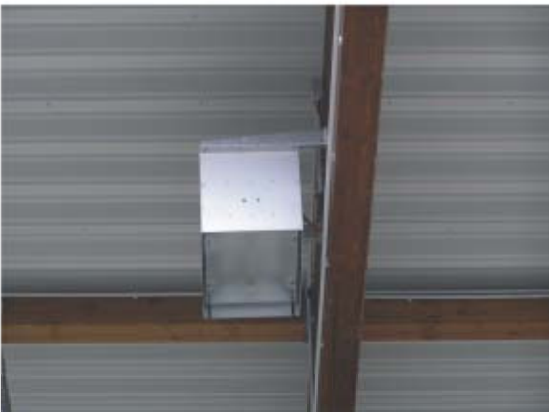
Die Reflektor-technik erlaubt größtmögliche Lichtpunktabstände, die Architektur und Deckenkonstruktion wird nicht beeinträchtigt.
