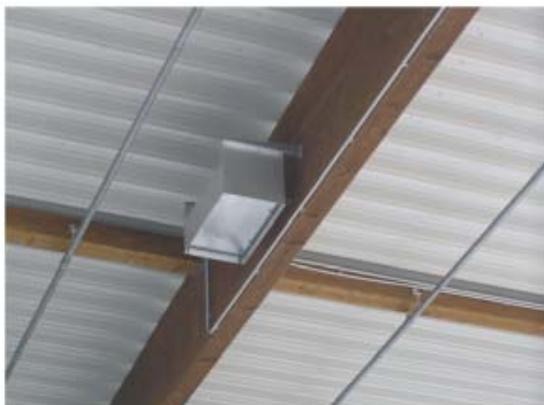
Die Reflektor-technik erlaubt größtmögliche Lichtpunktabstände, die Architektur und Deckenkonstruktion wird nicht beeinträchtigt.
